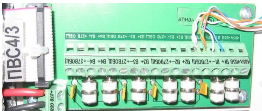
Рисунок 8.10. Подсоединение линии связи к плате подключения ПВС4
