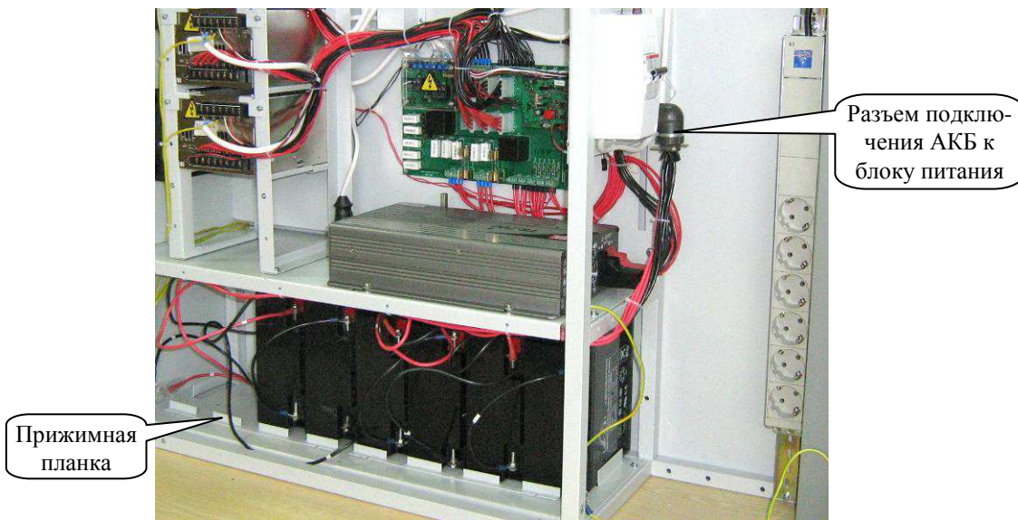
Рисунок 7.8. Установка АКБ.
