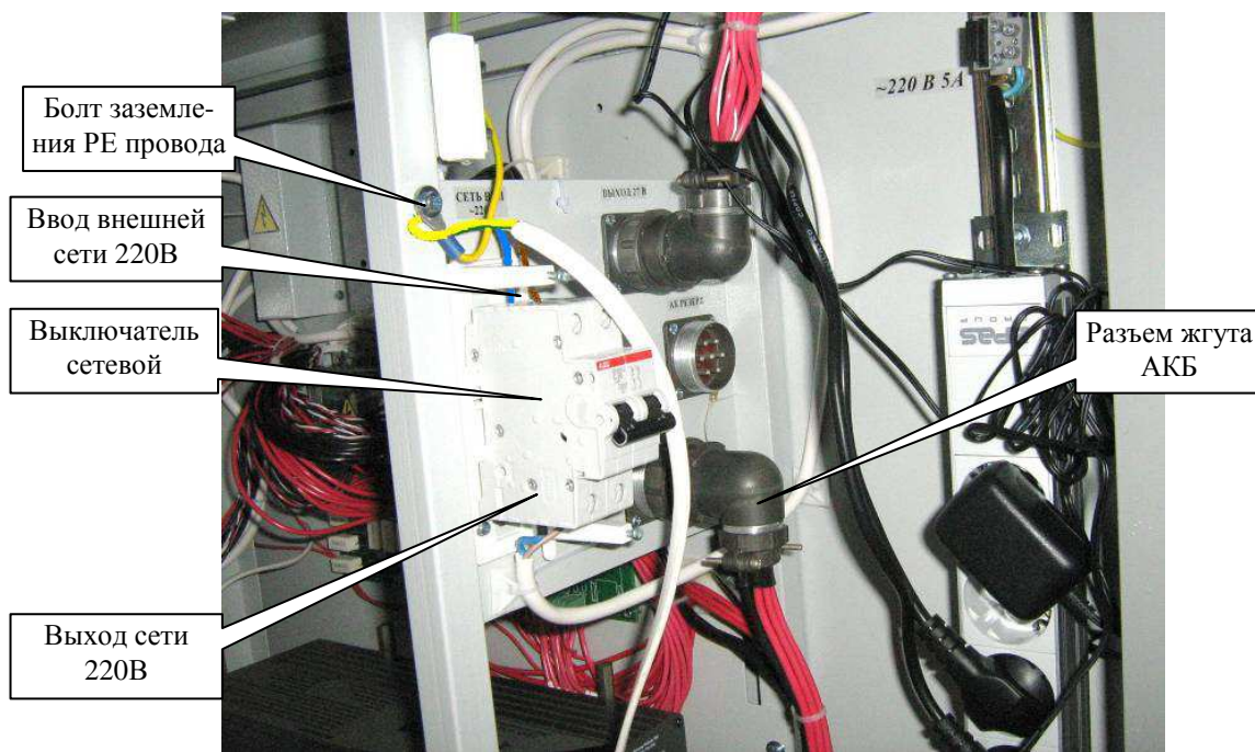
Рисунок 7.14. Подключение сети 220В
